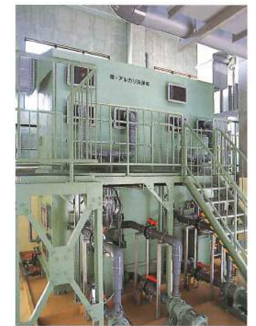
酸・アルカリ洗浄塔【中濃度】
