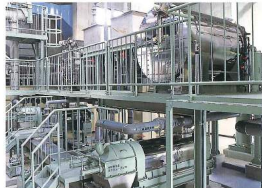
ドラムスクリーンとスクリーブレス(前処理設備)
